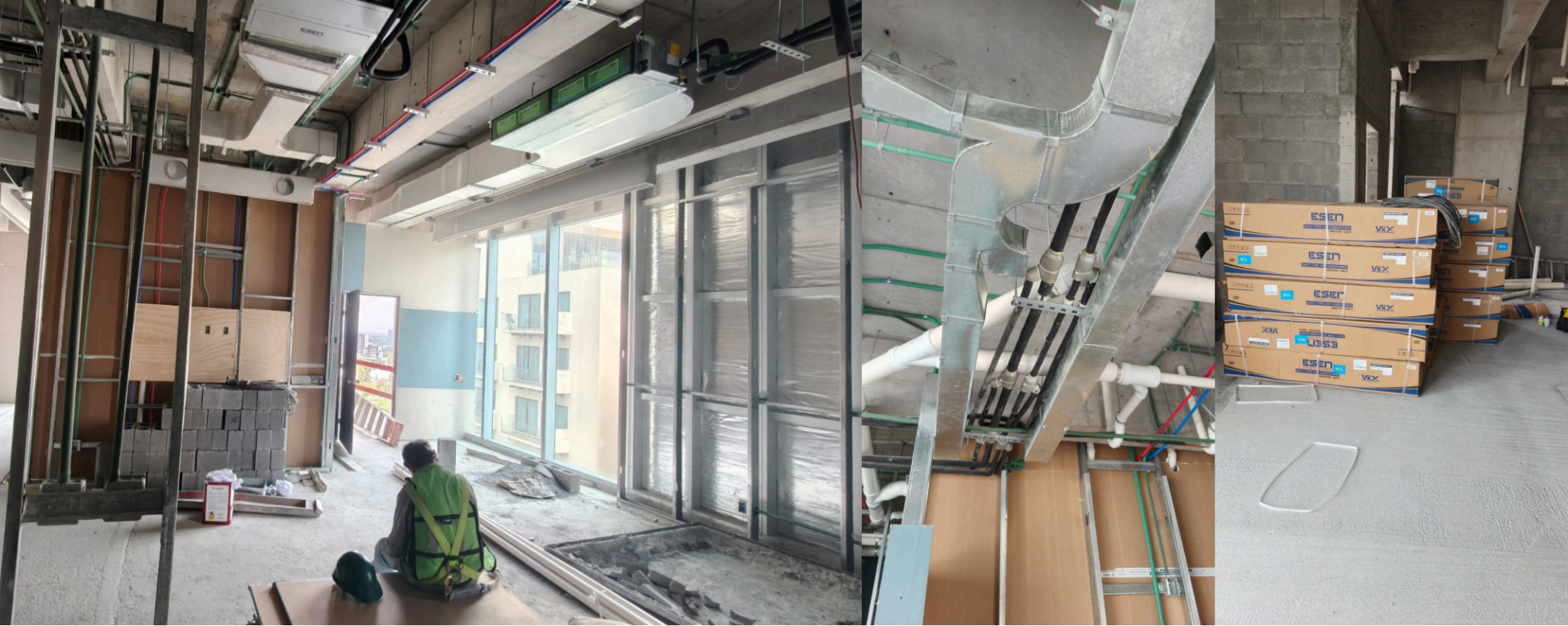
Instalación de equipos fin coil, Torre Eoma, Monterrey
